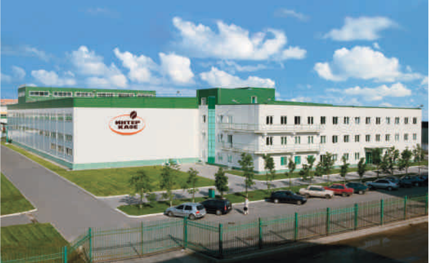
Produktions- und Verwaltungsgebäude der INTERCAFE in Moskau. The INTERCAFE production plant and office building in Moscow.
