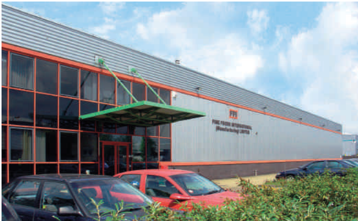
Produktionsgebäude der FFI in Dunstable, Großbritannien. The FFI production plant in Dunstable, Great Britain.
